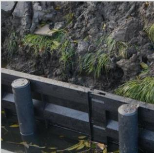
Aufgrund der hohen Steifigkeit der Paneele ist es möglich, diese mechanisch in den Untergrund zu drücken. Insbesondere die feste und stabile Verbindung der Paneele untereinander erlaubt es die Kombipfosten beliebig zu platzieren und nicht, wie bei anderen Systemen, genau an dieser Schnittstelle aufzustellen. Daraus ergibt sich eine große Zeitersparnis, weil erst die Kombipfosten aufgestellt werden können und dann erst die Paneele.
