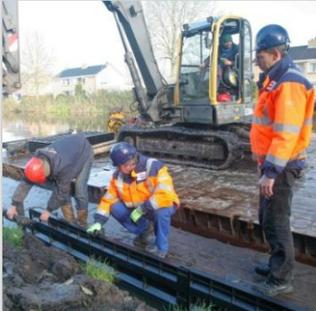
Das **KLP® RapidRetain Böschungssystem** ist eine dauerhafte und kosteneffiziente Lösung für Ihre Ufersicherung. Gerade an der Schnittstellen von Wasser und Luft, wo alle Holzarten am meisten anfällig für Fäulnis sind, ist KLP® Kunststoff eine hervorragende Alternative. Das KLP® RapidRetain Böschungssystem besteht aus KLP® RapidRetain Paneelen und KLP® Kombipfosten.
