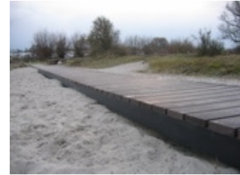
Strand- und Geländewege mit KLP-Decksbohlen und Konstruktionsbalken Stahl armiert und mit Glasfaser verstärkt
