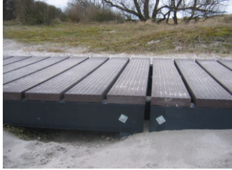
KLP-Decksbohlen geriffelt Unterbau Stahlarmierte Träger
