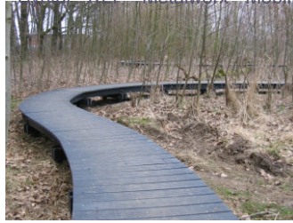
Strand- und Geländewege mit KLP-Decksbohlen und Konstruktionsbalken Stahl armiert und mit Glasfaser verstärkt
