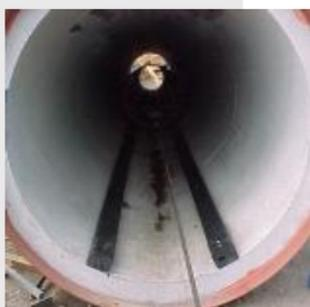
Unsere KLP® Fender sind außerdem sehr geeignet für Anwendung außerhalb des Wasserbaus, z.B. als Stosrand an Stützmauern in Toreinfahrten. Und sie wurden auch schon gebraucht für den Bau von Wasserleitungen. Das Wasser lief in diesem Fall durch stählerne Röhren, die in ein Betonrohr gezogen werden mussten. Um den Widerstand im Betonrohr zu vermindern, wurde der KLP® Fender angewendet.
