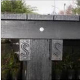
Der KLP® Pfahlkopf ist die Alternative zu hölzernen Fundamentpfählen für unter anderem Anlegestege und Poller. Der KLP® Pfahlkopf ist ein perfektes Aufsatzstück für Holzpfähle, weil auf diese Weise an der Schnittstelle zwischen Wasser und Luft kein Zerfall auftritt und keine Wartung notwendig ist. Die Kombination von Holz und Kunststoff resultiert ausserdem in einem besonders festen Fundamentpfahl und ist eine preiswerte Lösung.
