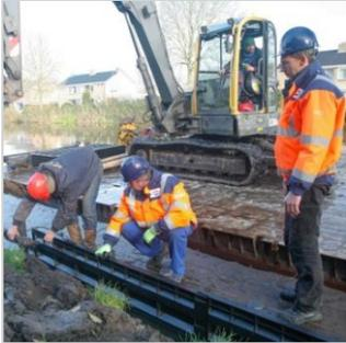
Das **KLP<sup>®</sup> RapidRetain Böschungssystem** ist eine dauerhafte und kosteneffiziente Lösung für Ihre Ufersicherung. Gerade an den Schnittstellen von Wasser und Luft, bei denen alle Holzsorten am meisten anfällig für Fäulnis sind, ist KLP<sup>®</sup> Kunststoff eine hervorragende Alternative. Das KLP<sup>®</sup> RapidRetain Böschungssystem besteht aus KLP<sup>®</sup> RapidRetain Paneelen und KLP<sup>®</sup> Kombipfosten.
