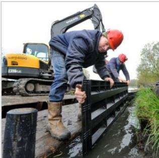
Aufgrund der hohen Steifigkeit der Paneele ist es möglich, diese mechanisch in den Untergrund zu drücken. Insbesondere die feste und stabile Verbindung der Paneele untereinander erlaubt es, die Kombipfosten beliebig zu platzieren und nicht, wie bei anderen Systemen, genau an der Schnittstelle aufzustellen. Daraus ergibt sich eine große Zeitersparnis, weil erst die Kombipfosten in einem Arbeitsgang aufgestellt werden können und dann erst die Paneele.
