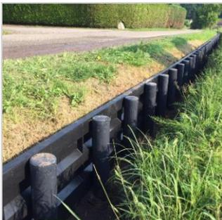
Die Paneele haben eine optimale Länge von 2,1 Meter und sind sehr leicht. Somit sind die Paneele einfach zu handtieren und zu montieren. Lankhorst empfiehlt die Verwendung von Geotextilien. Es gibt Situationen, in denen dies nicht notwendig ist. Dies sollte man pro Projekt bewerten.
